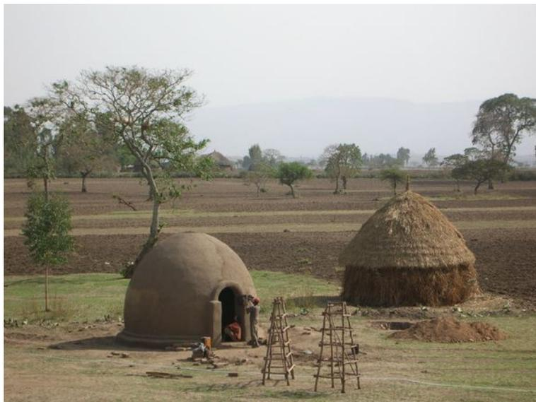
*Un altro esempio di tecnologia appropriata: un granaio costruito in blocchi di terra, senza impiego di legno. Realizzato a Ropi, Etiopia, con il supporto dell'Università di Genova nel 2006*
